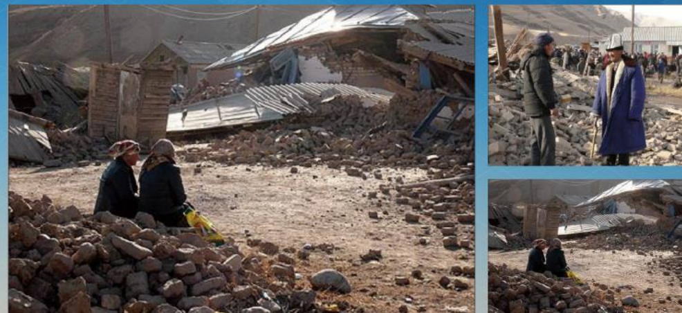
キルギス・ヌーラ地震(Mw=6.6) 2008年10月5日
